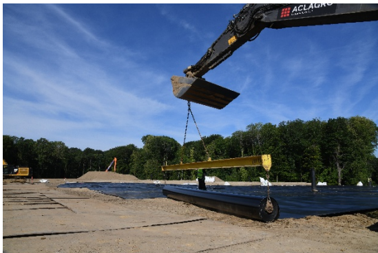
Confinement : pose des membranes étanches.
