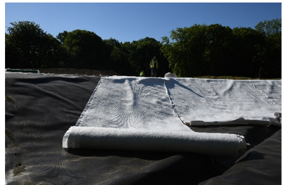
Confinement : pose des membranes étanches.
