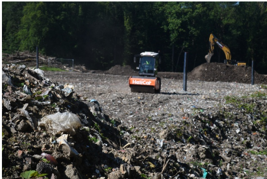
Reprofilage du massif de déchets avant confinement.
