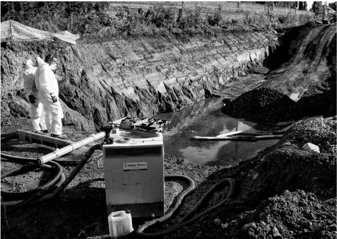
➔ Cokerie Flémalle : de la cokerie désaffectée à la plateforme logistique trimodale
