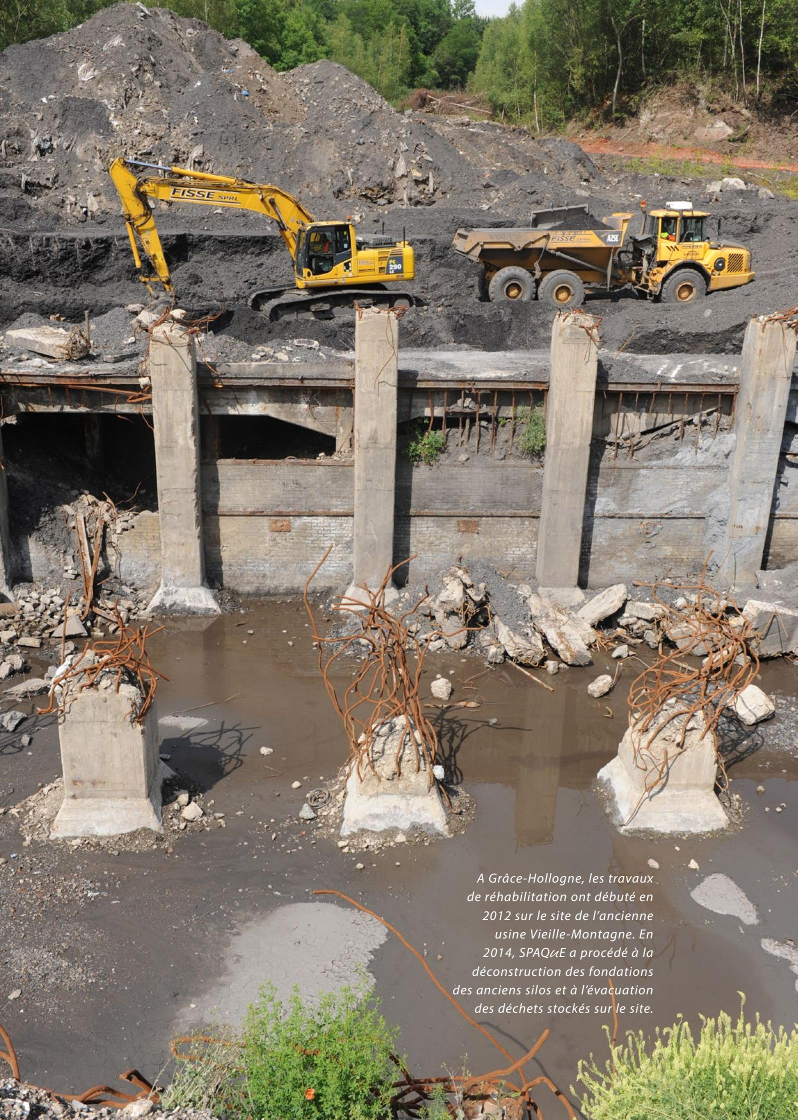
*A Grâce-Hollogne, les travaux de réhabilitation ont débuté en 2012 sur le site de l'ancienne usine Vieille-Montagne. En 2014, SPAQUE a procédé à la déconstruction des fondations des anciens silos et à l'évacuation des déchets stockés sur le site.*
