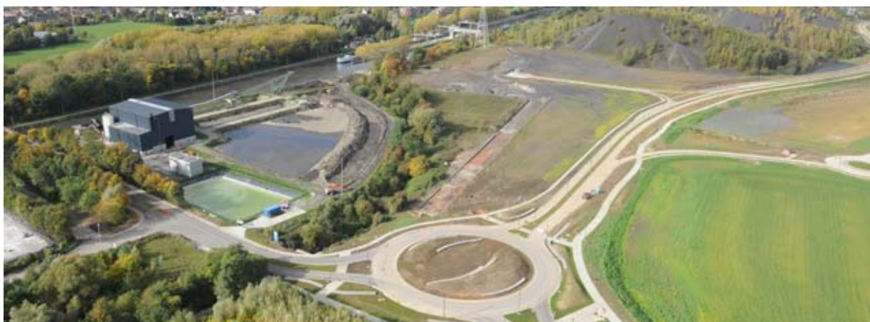
Vue des installations SEDISOL
