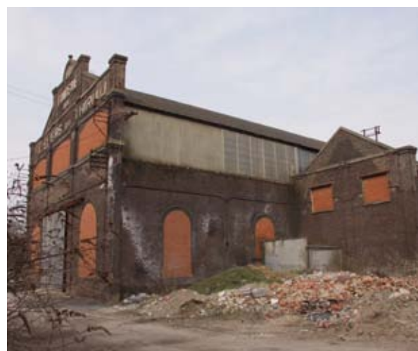
Vue du site avant réhabilitation
