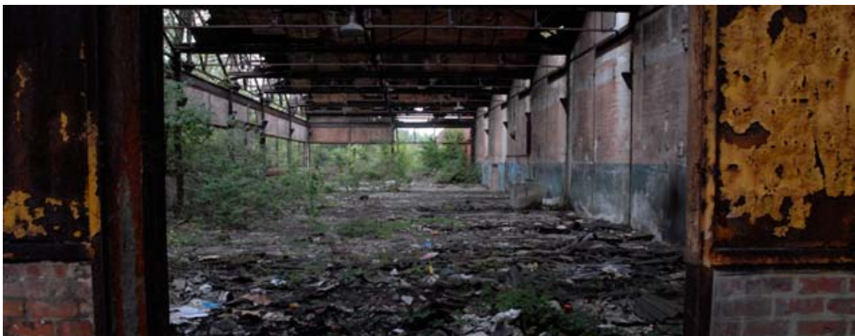
Vue d'ensemble du site avant réhabilitation
