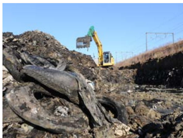
Évacuation des déchets
