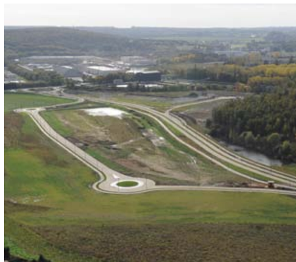
Vue partielle du site Ecopôle
