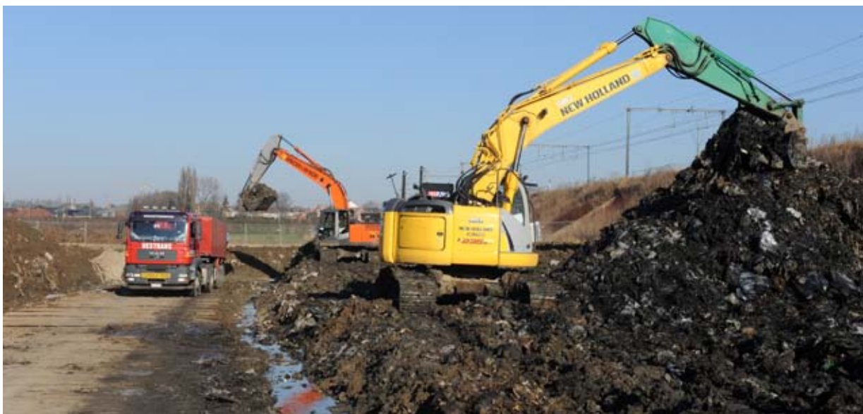
Évacuation des déchets
