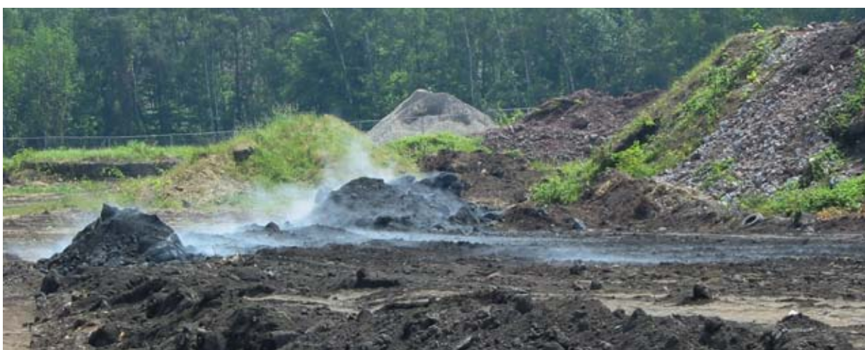
Vue du site en réhabilitation
