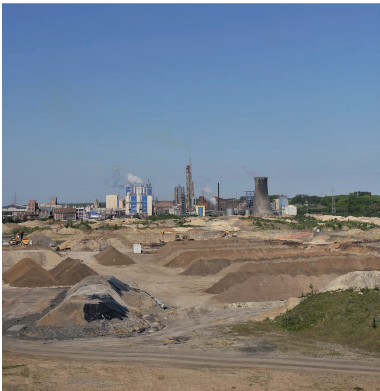
C'est à Tertre, commune de Saint-Ghislain, que fut exploitée la plus grande cokerie de Belgique sous la dénomination de Carcoke. Aujourd'hui, ce site est en cours de réhabilitation par SPAQuE qui y a excavé les sols pollués à plus de dix mètres de profondeur par endroits.
