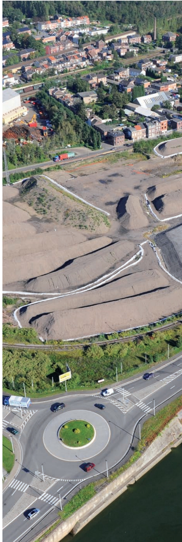
Situé le long de la Meuse, à proximité de l'autoroute et relié directement au chemin de fer, le site Cokerie Flémalle est destiné à devenir une plateforme multimodale.
