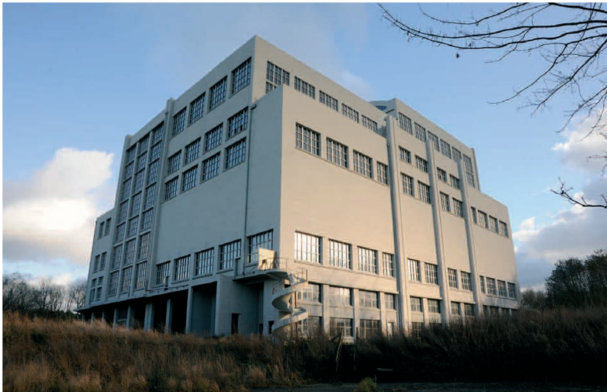
Le bâtiment du "Triage-Lavoir du Centre", à Binche, restauré.
