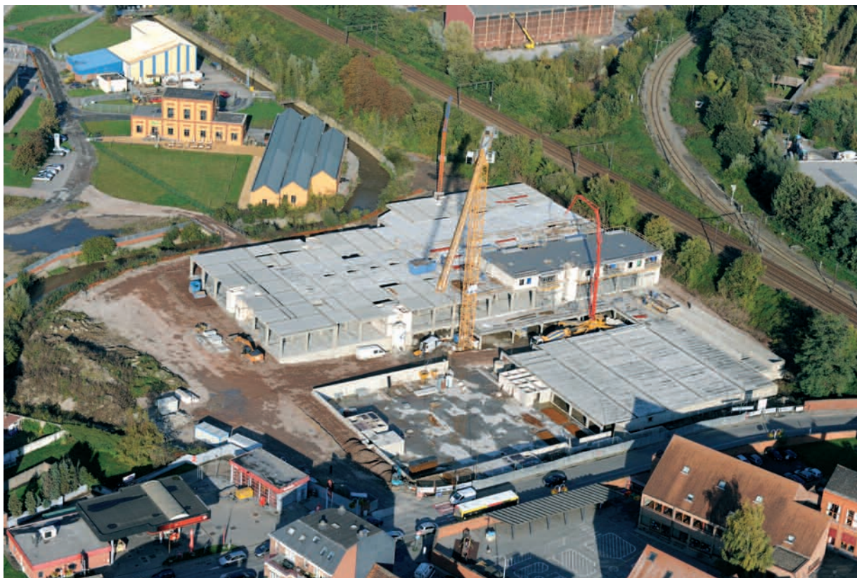
Un complexe commercial est en construction sur le site "Tubize Plastics" à Tubize, réhabilité par SPAQuE.
